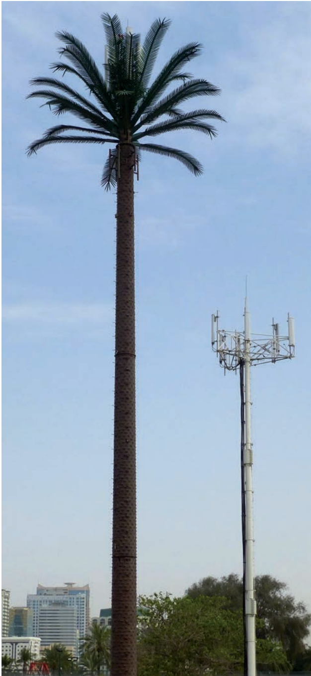
Abbildung 1: Unübersehbare Infrastruktureinrichtungen für mobile Kommunikation in einer ubiquitären Stadt: mehr oder minder ästhetisch ansprechende Antennen. In Sharjah, V.A.E., hat man den Versuch unternommen, Antennen als Palmen zu tarnen.
