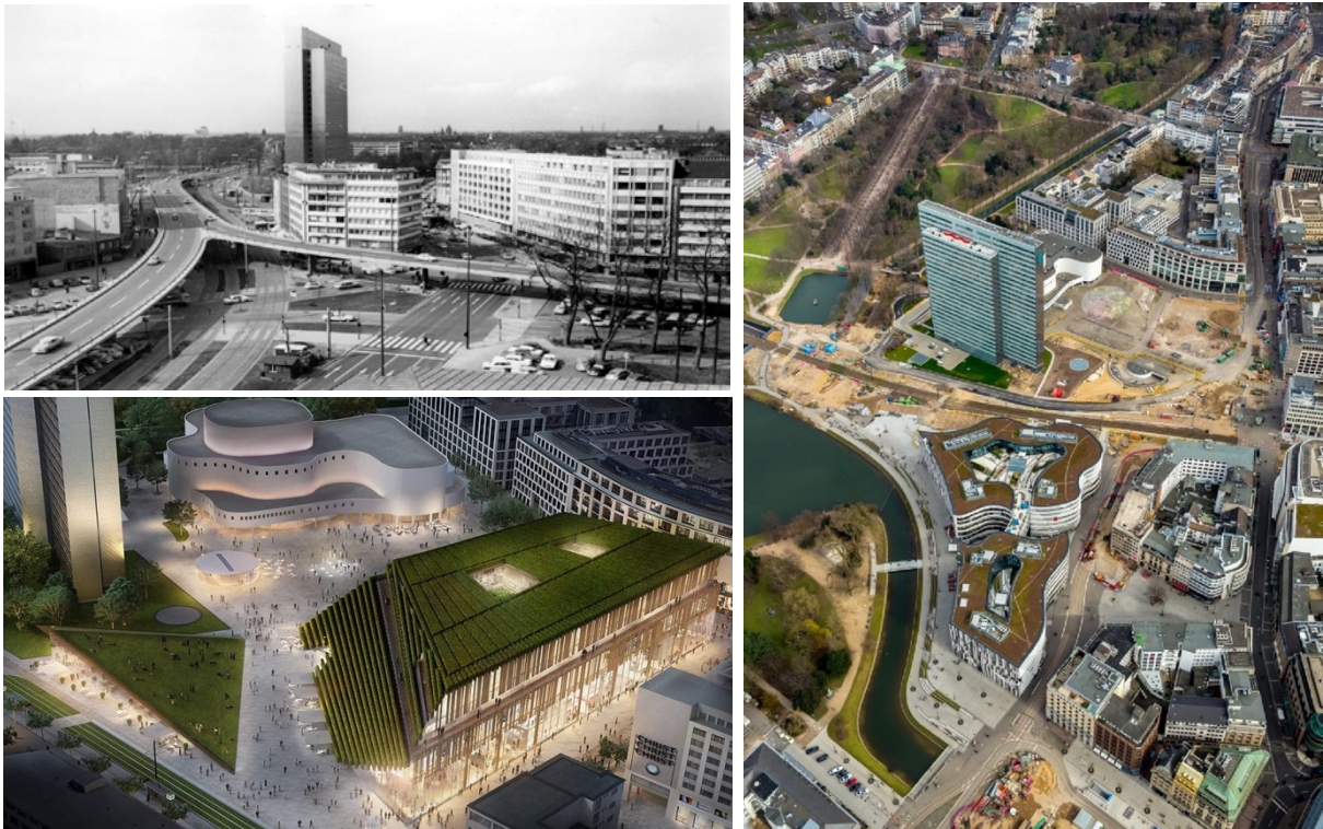
Abbildung 13. Ehemalige Autohochstraße am Jan-Wellem-Platz 1963 (oben links), der Platz im März 2017 und der geplante Entwurf für den Köbogen 2. Quelle oben links: Rheinbahn AG (2013b), Quelle rechts: Euroluftbild.de (2017), Quelle unten links: Ingenhoven Architects
